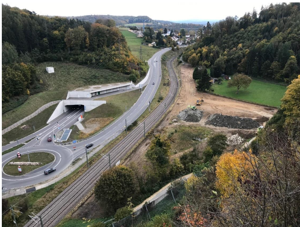
Foto: Aufwertungsprojekt «Aalte Iiswaier» während der Bauphase
